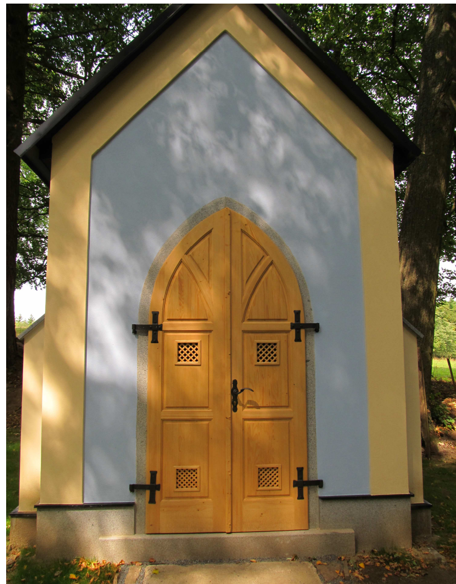
Kaple Sv.Hildegardy po rekonstrukci
